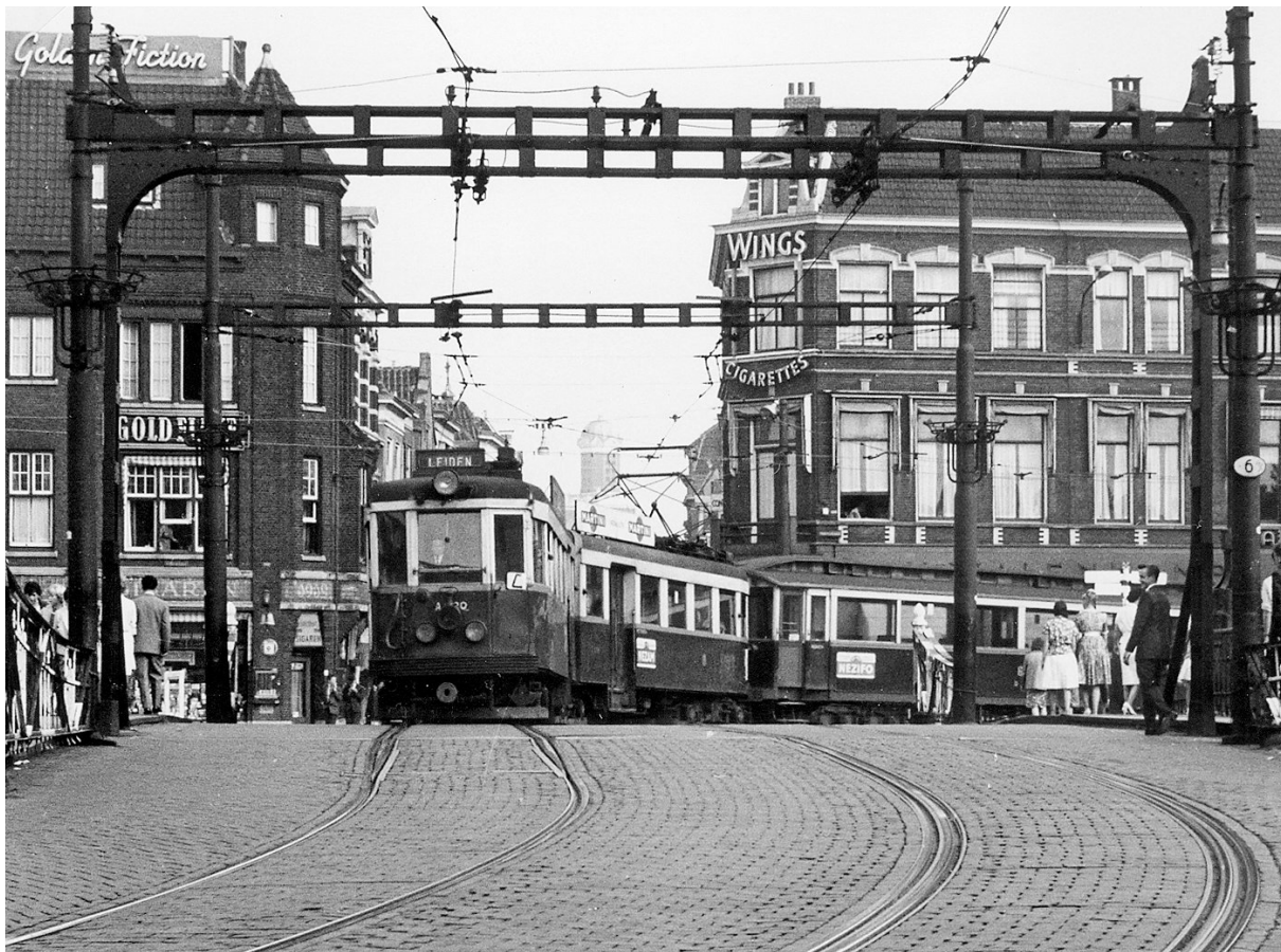
Blauwpoortsbrug, A 620/619 + B 22. Leiden, 3 september 1961.
