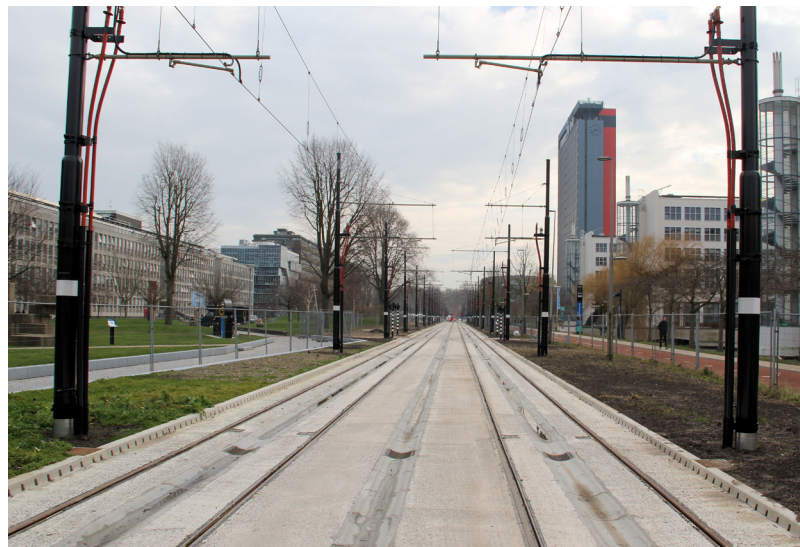
Mekelweg voorzien van bovenleiding. Nu de afwerking en proefmetingen nog.
